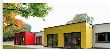
Exemple d'une crèche construite en modulaire
